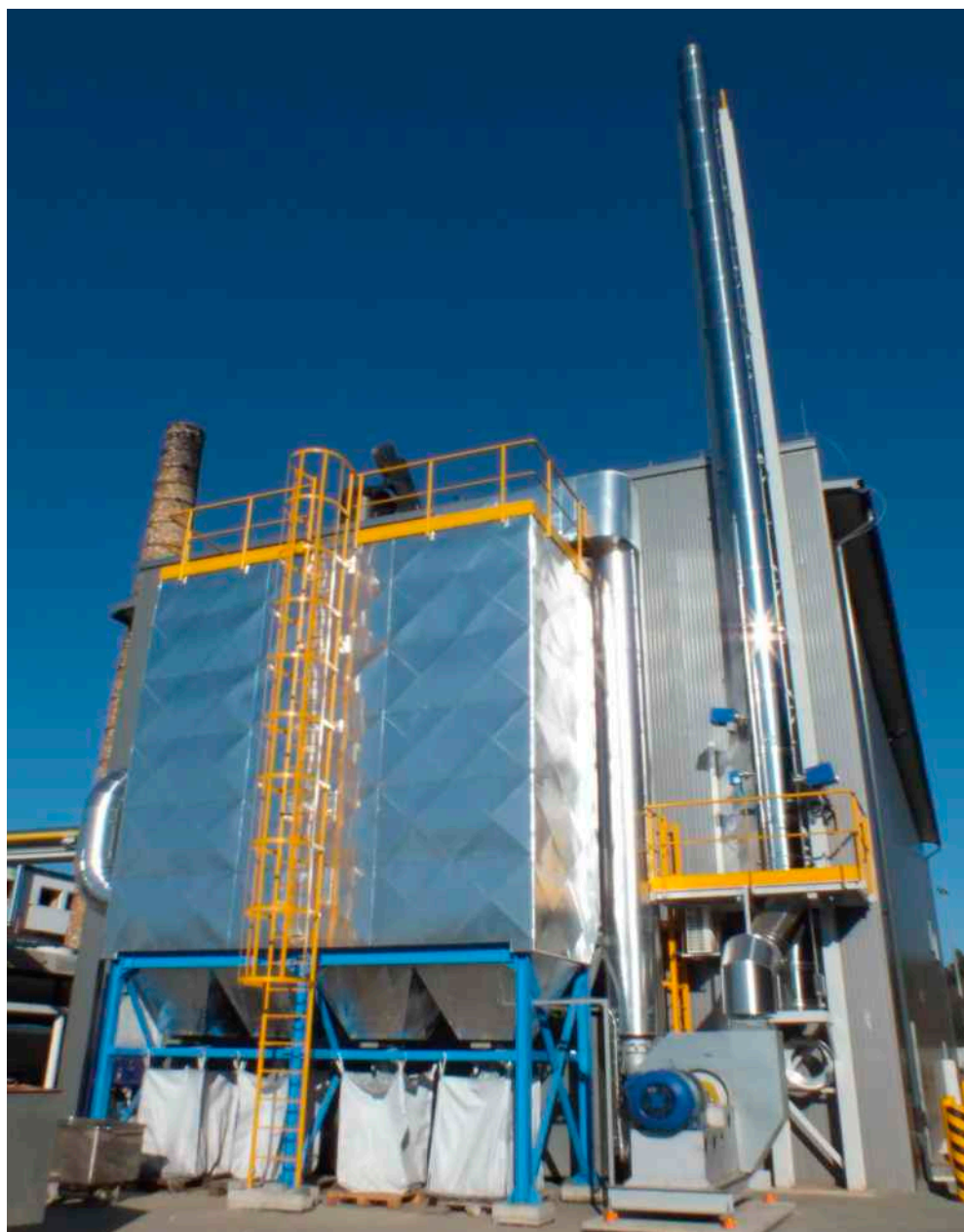
Filtr workowy wraz z wentylatorem wyciągowym i kominem
