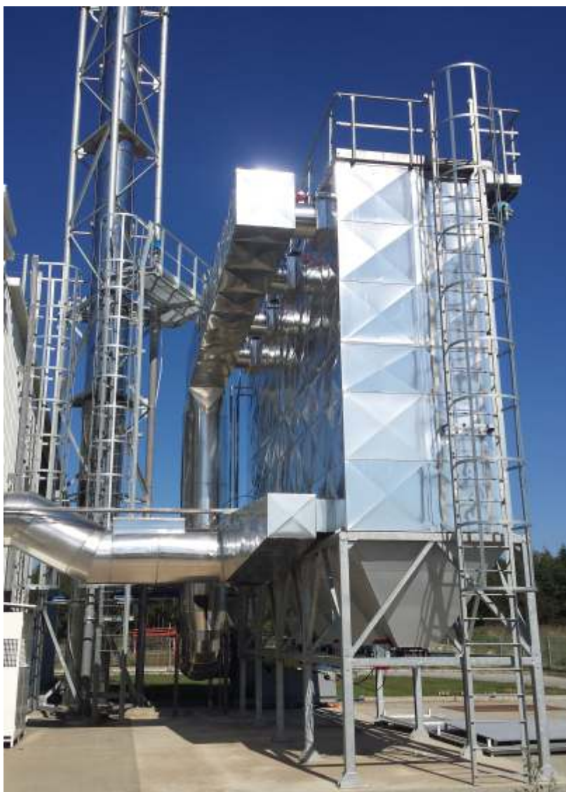
Filtr workowy wraz z wentylatorem wyciągowym i kominem.
