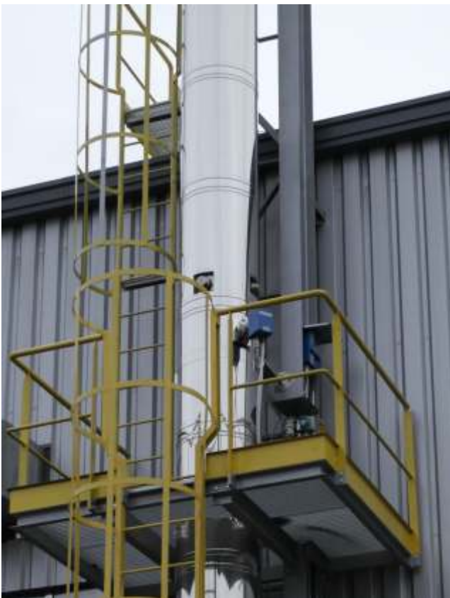
Układ poboru i transportu próbki gazowej oraz pomiaru zapylenia i parametrów referencyjnych.
