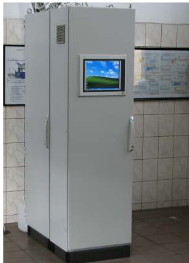
Szafa pomiarowa z analizatorami oraz z częścią przetwarzająco-obliczeniową.
