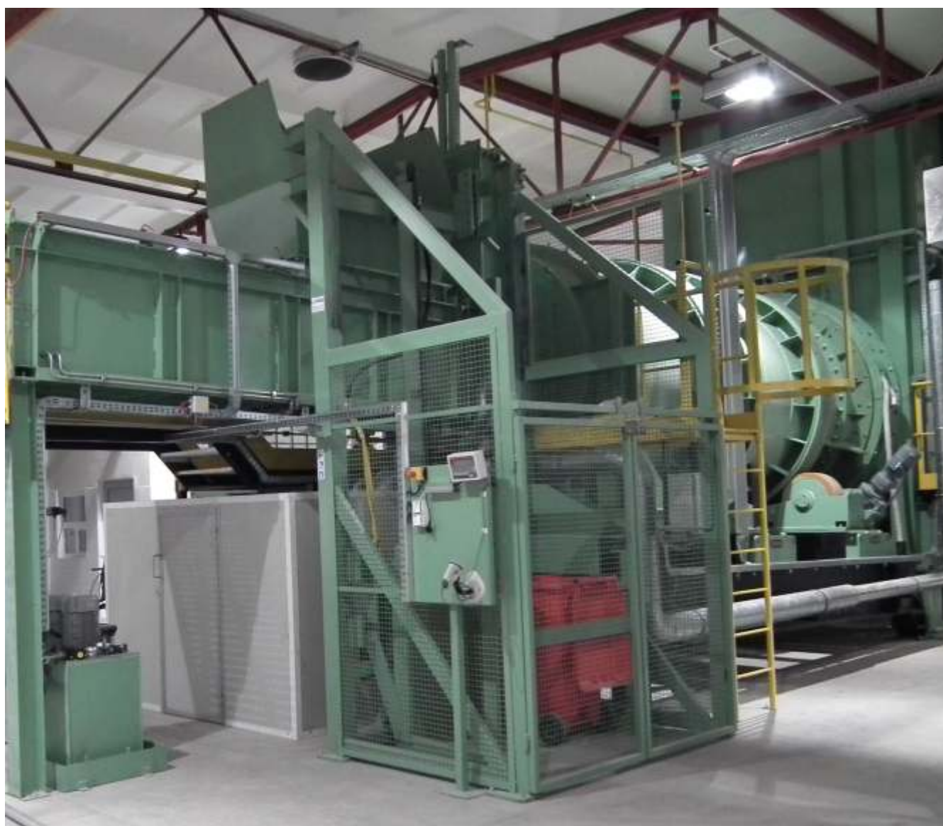
Winda + tłoki hydrauliczne.
