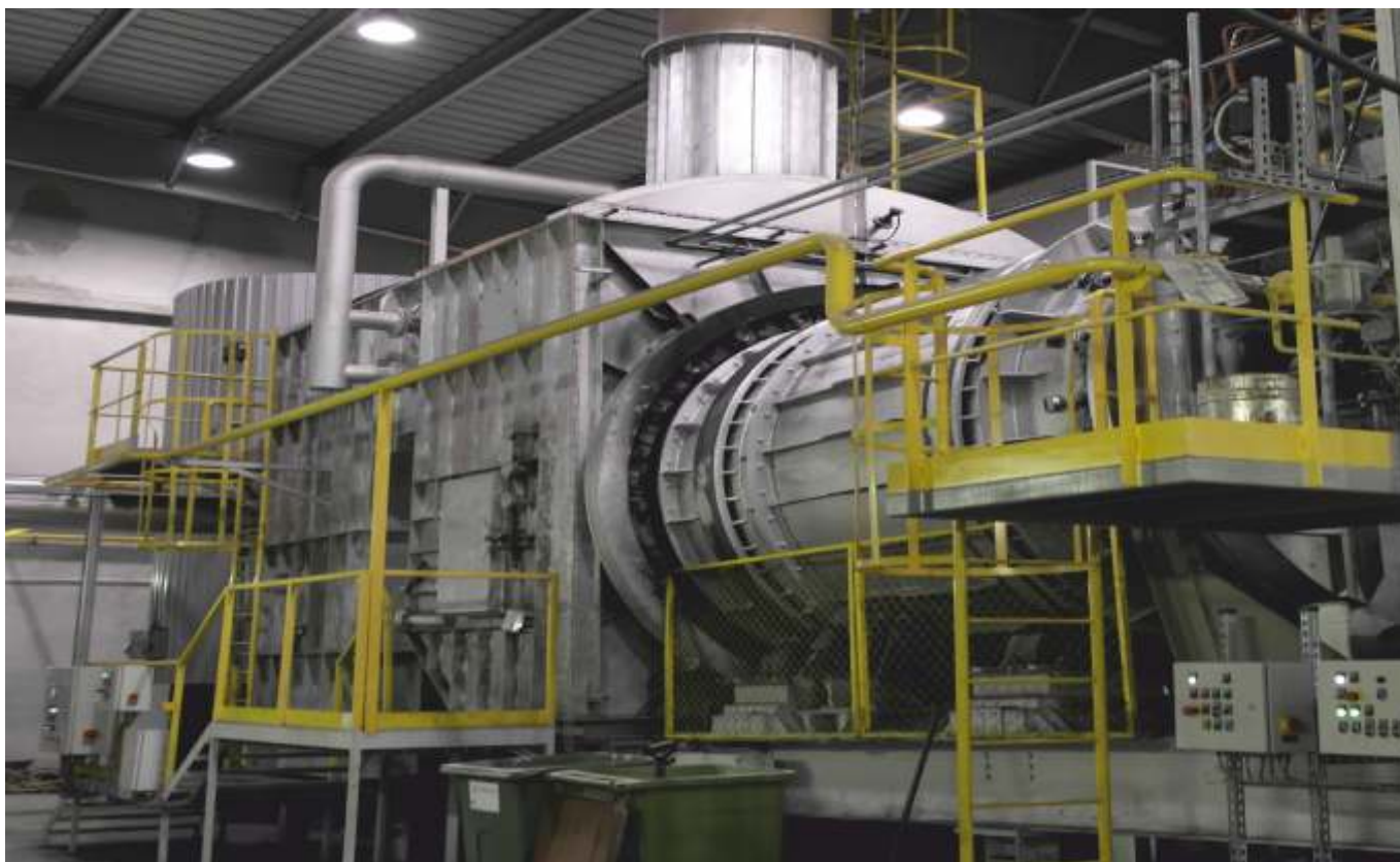
Spalarnia odpadów z tworzyw sztucznych - SABA Sp. z o.o. w Płocku.
