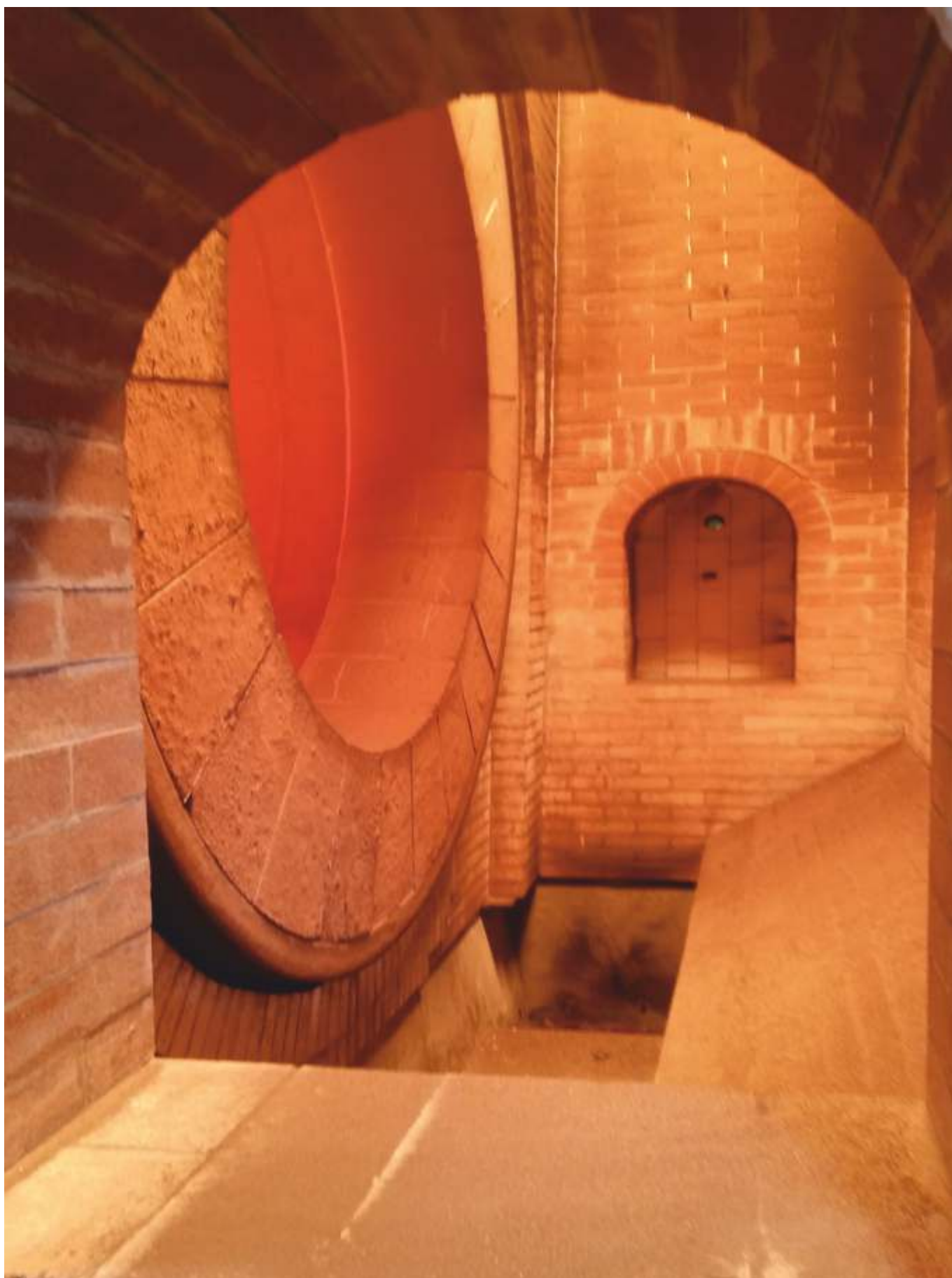
Wlot do komory dopalania - widok od wewnątrz.
