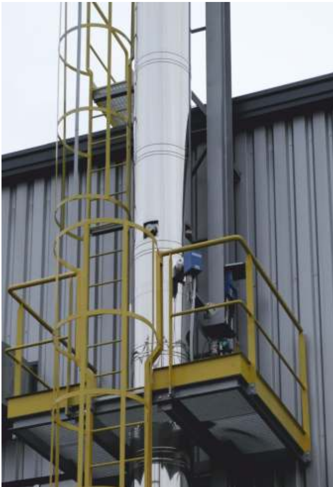
Układ poboru i transportu próbki gazowej oraz pomiaru zapylenia i parametrów referencyjnych.
