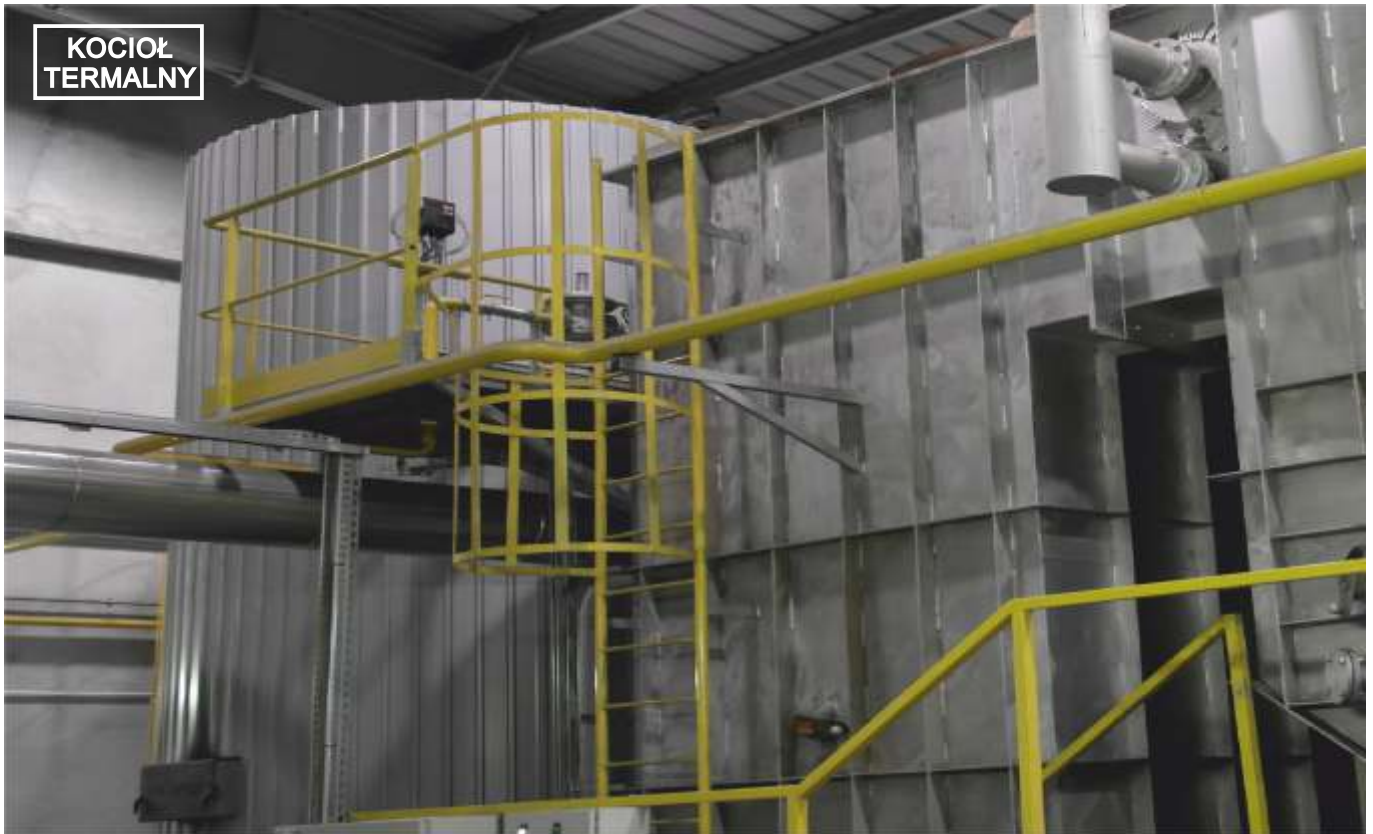
Odzysk ciepła w postaci oleju termalnego.
