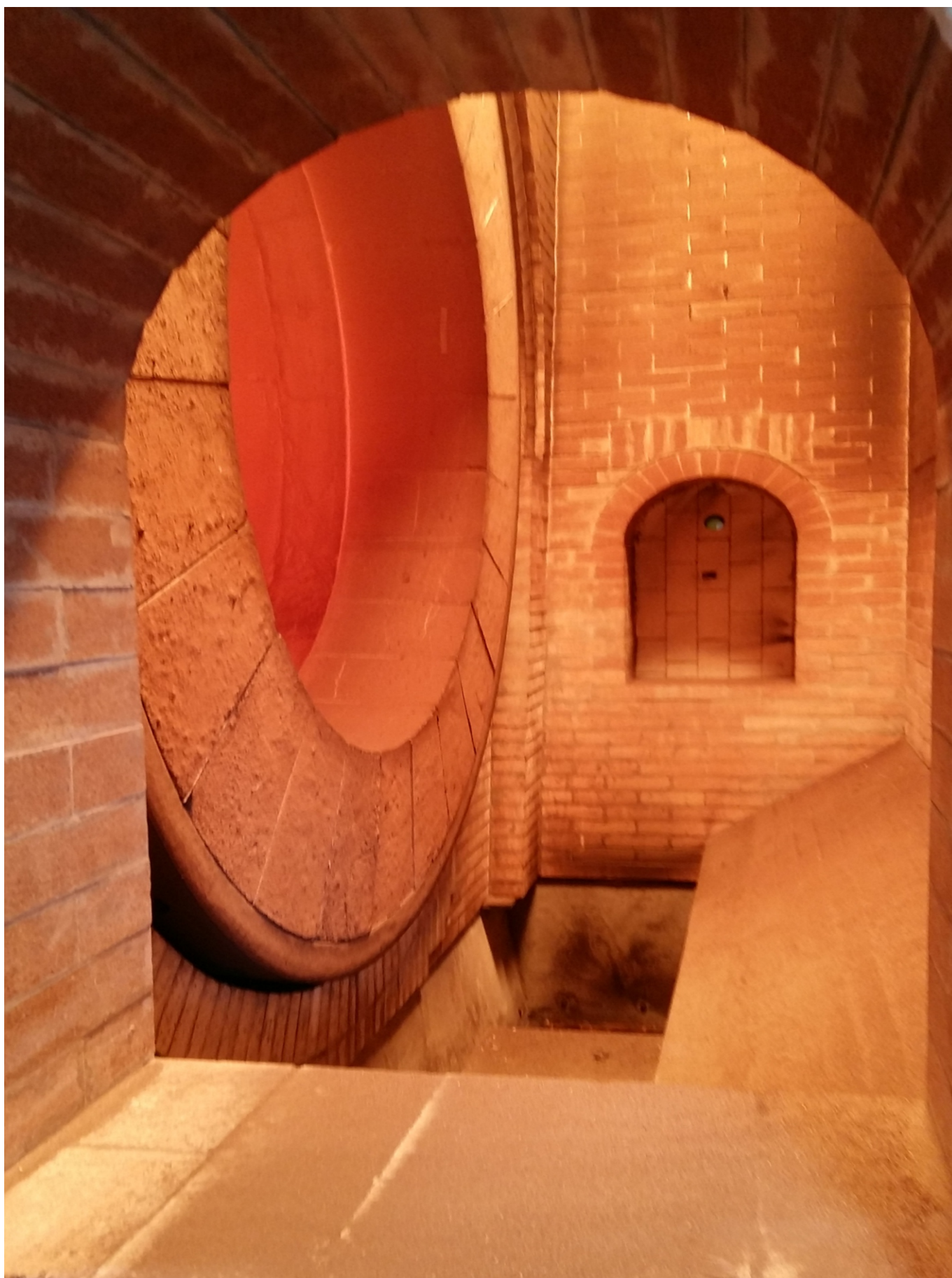
WŁOT DO KOMORY DOPALANIA - POŁĄCZENIE PIECA OBROTOWEGO Z KOMORĄ DOPALANIA (WIDOK OD WEWNĄTRZ)
