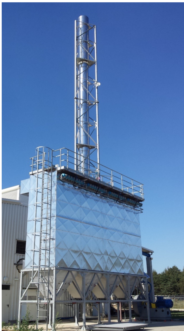
UKŁAD OCZYSZCZANIA SPALIN
