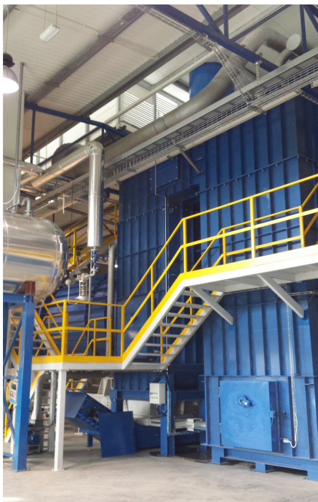
KOMORA DOPALANIA O WYDAJNOŚCI 800 kg/h
