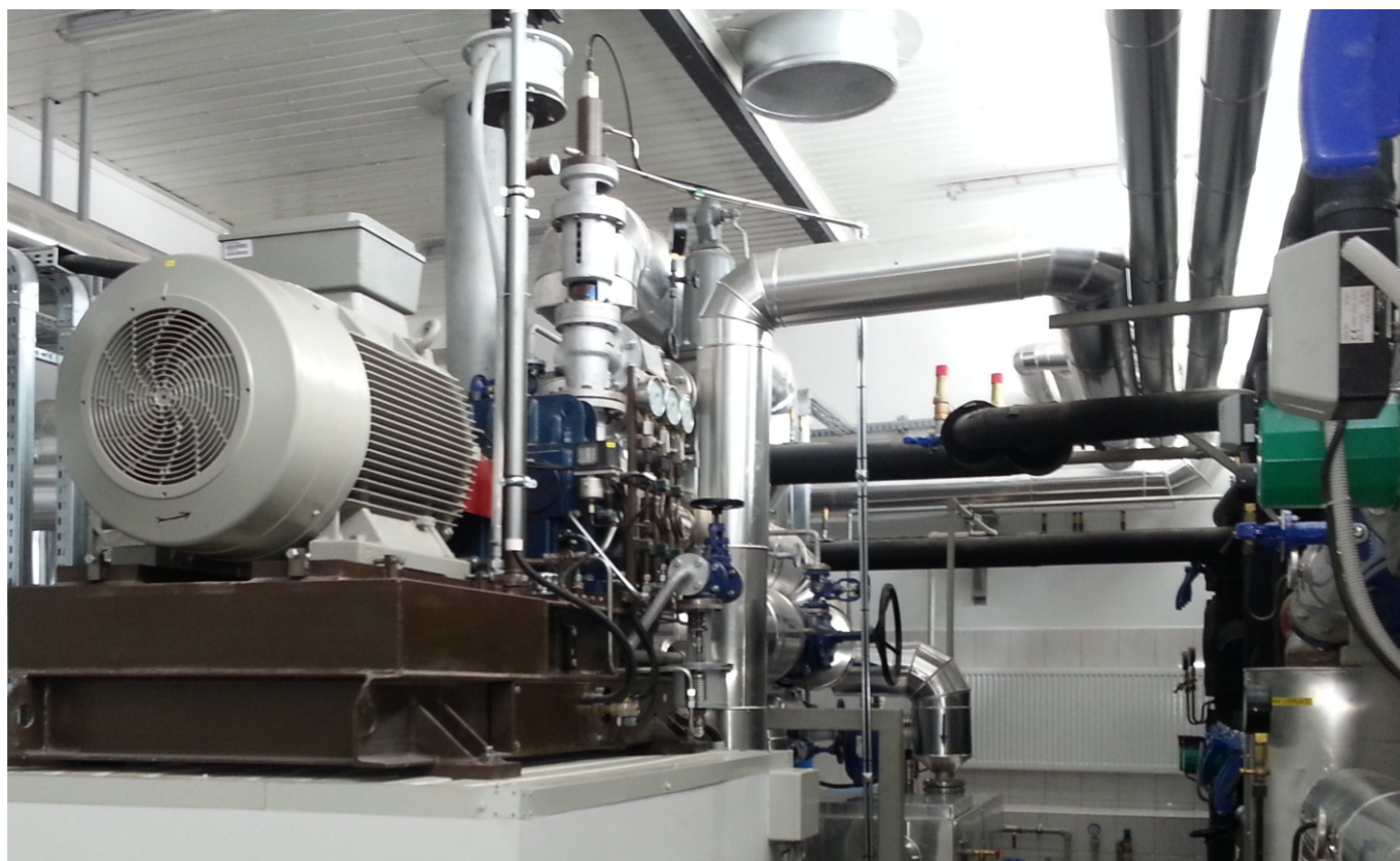
MIKROTURBINA PAROWA O MOCY N = 100 KWe
