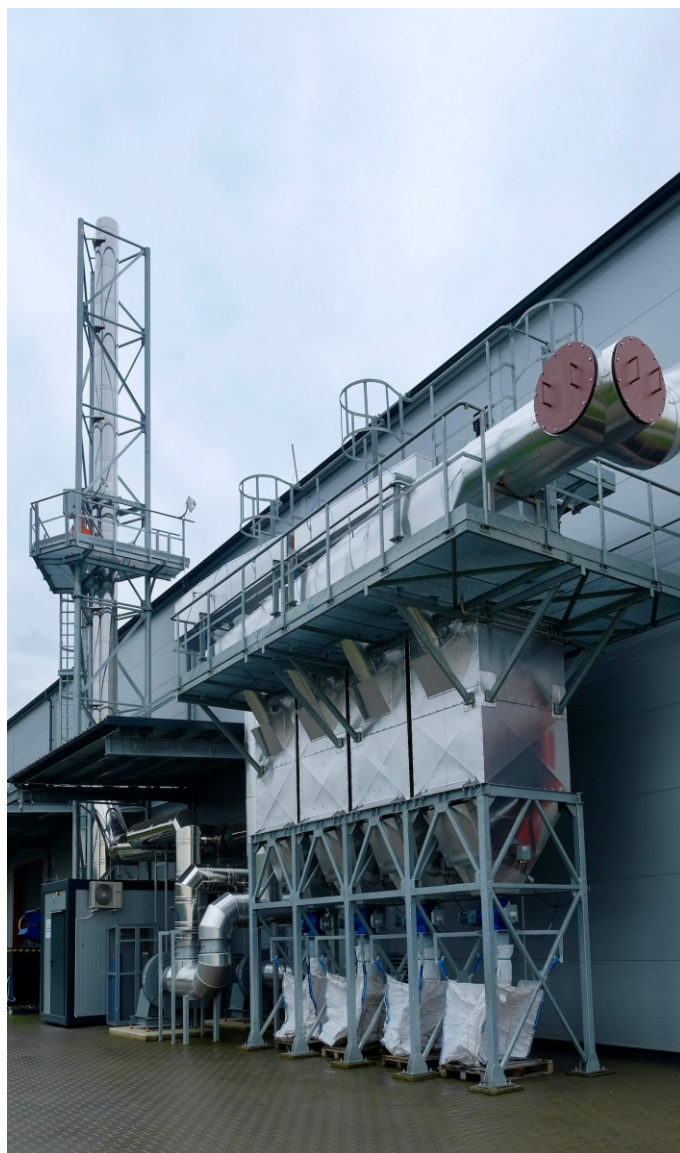
UKŁAD OCZYSZCZANIA SPALIN
