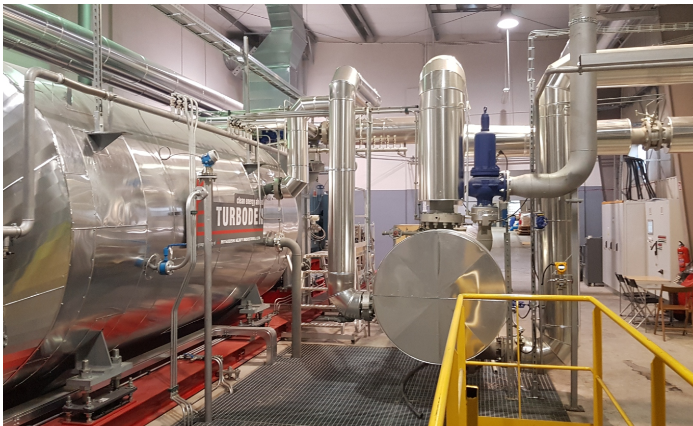
MODUŁ PRODUKCJI ENERGII ELEKTRYCZNEJ ORC O MOCY N = 1250 \text{ kW}_e
